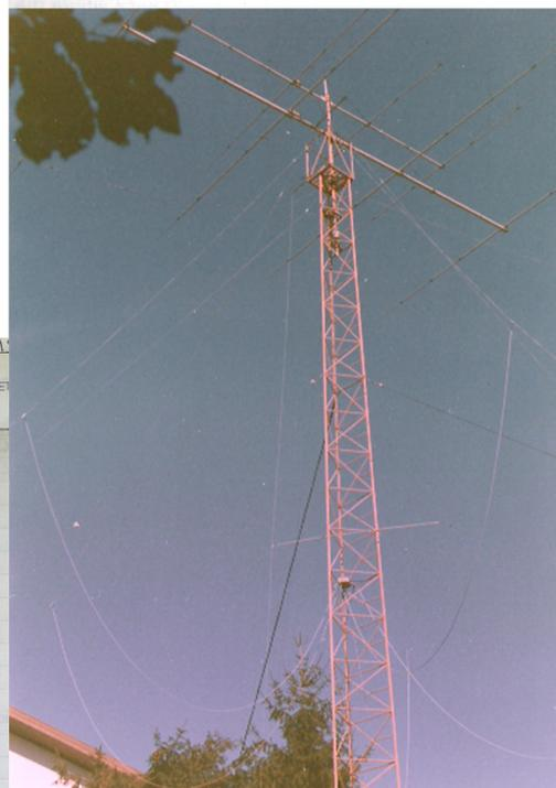
È consigliabile partire con un filo lungo circa 54 metri e poi accorciarlo un po' alla volta durante la taratura, per la quale è sufficiente il misuratore di onde stazionarie. La curva del SWR è piuttosto larga, come si vede qui sopra, ed io sono riuscito a portarlo sotto 1.3 da 1.800 a 1.850 KHz, più che soddisfacente.
